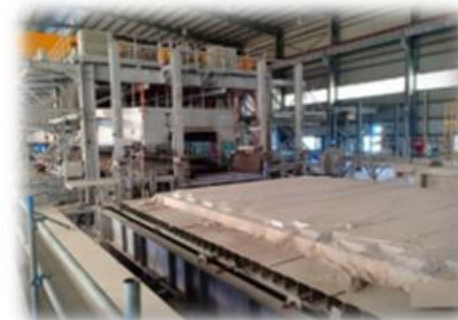
↑ 設備据付工事の状況（ベトナム）
