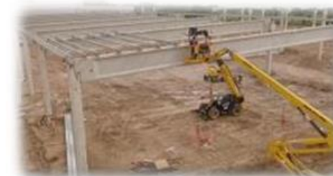
↑ 建屋工事の状況（アルゼンチン）
